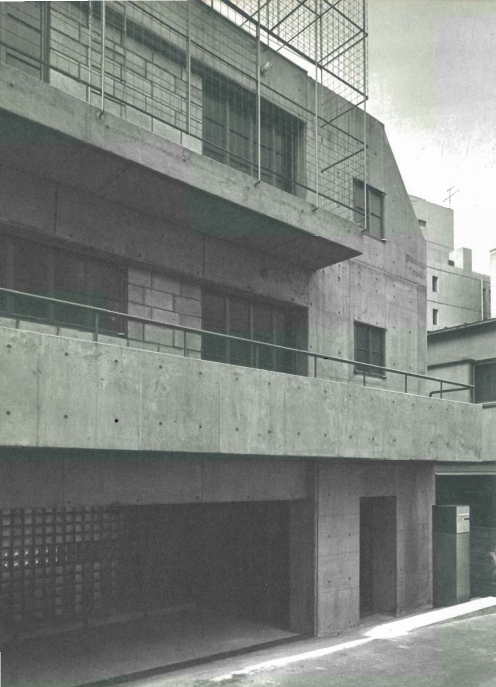
東側外壁をみる 外壁 コンクリート打放し防水剤ロープ塗り こちら側は住宅部分の入口となっている 事務所側車庫よりみた事務所入口
