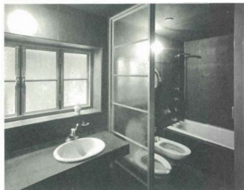
3階洗面・浴室をみる 床・壁 玄昌石貼り
