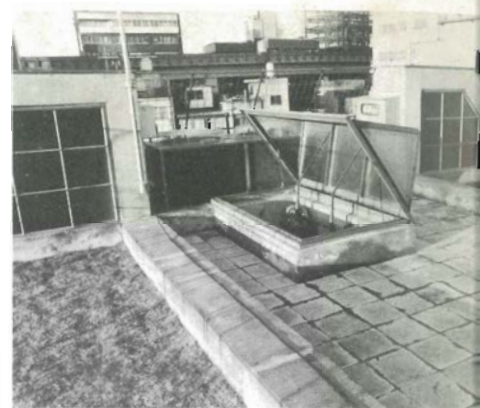
屋上: トップライトが開いている状態
